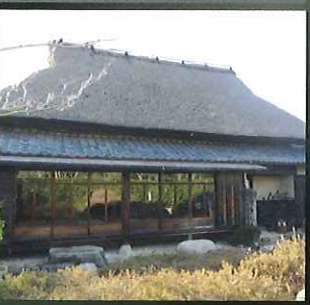
13 金剛苑茅葺屋根の家
