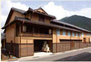
出石永楽館外観
